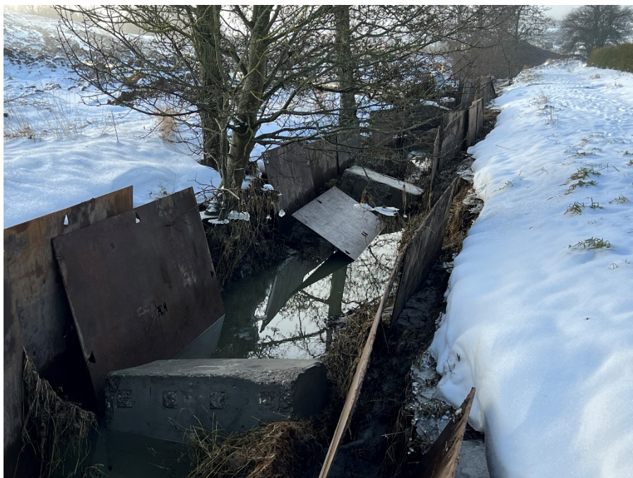
Figur 2 Foto af området nedstrøms udpumpningsstedet. Store betonklodser og køreplader udlagt for at bremse vandets kraftigt.
