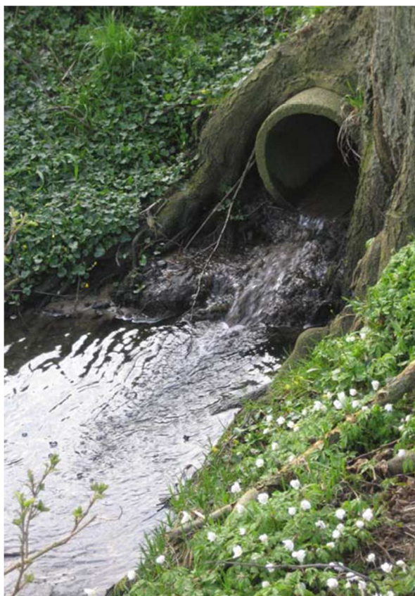
Kloakudløb i vandløb ved Laksevej i Langå.
