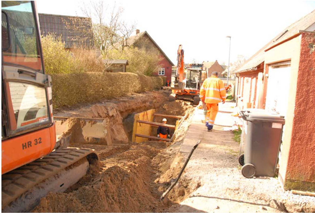
Kloakfornyelse i Råby.
