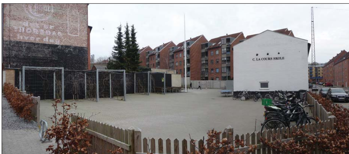
Grunden i dag set fra hjørnet mellem Sennelsgade og Jyllandsgade. Skolegård og eksisterende skolebygning.
