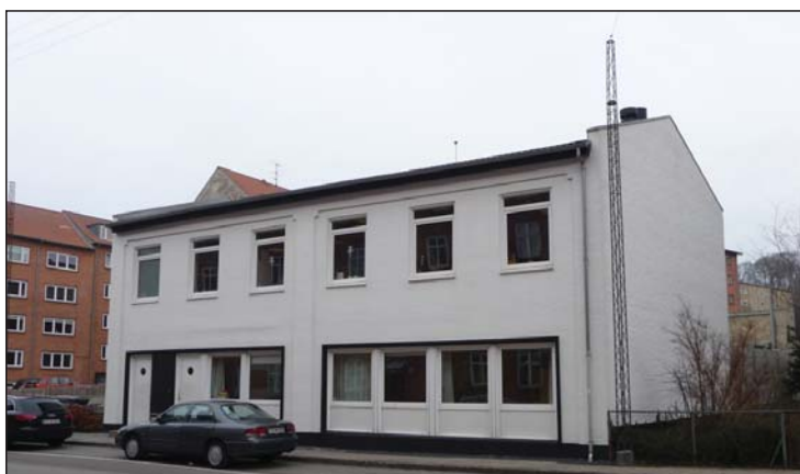
Eksisterende skolebygning til C. la Cours Skole på lokalplan-grunden set fra Jyllandsgade.
