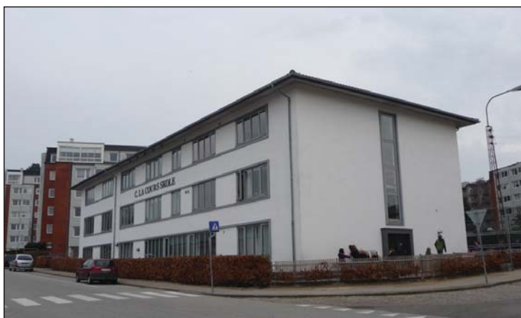
C. la Cours Skole på Jyllandsgade 24.
