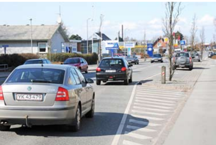
Trafiksanerung ved Mariagervej
