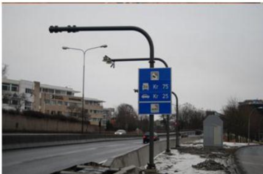
Figur 2. Eksempel på vejsideudstyr i "freeflow-system" fra Norge
