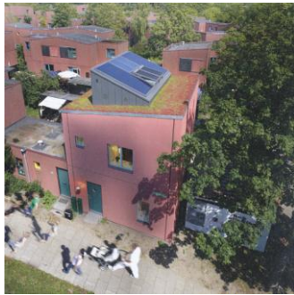
Solceller placeret som rytterelement på taget
