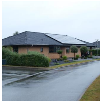
Ny villa med rektangulært panel der dækker ca. 50 % af den anvendte tagflade. Afstandene ved tagfod og rygning er for lille, hvilket svækker harmonien i husets proportioner
