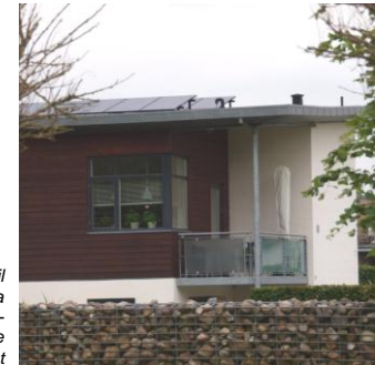
Panelerne er vinklet 15 grader i forhold til vandret plan. Afstandskravet på 150 cm fra tagkanten er overholdt. Panelernes tilstedeværelse på taget er diskret og svækker ikke helhedsindtrykket
