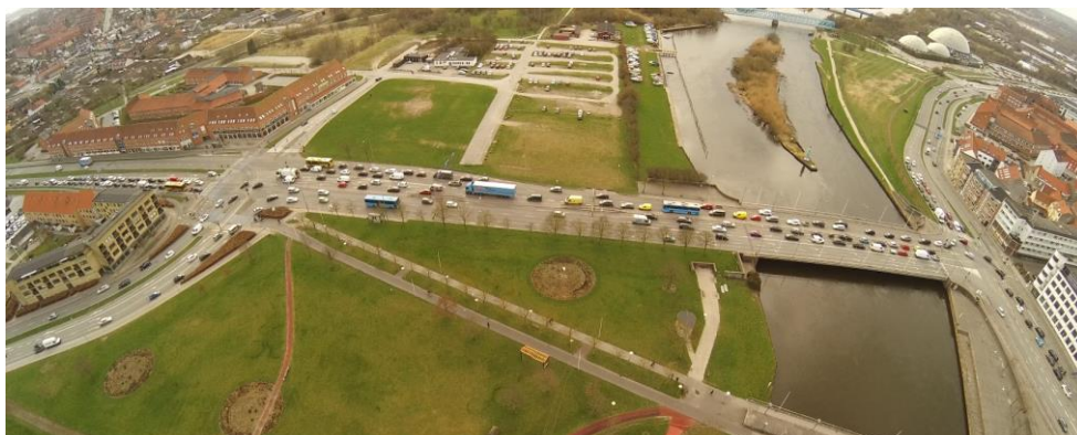
Figur 5 Dronebillede af krydset Århusvej/Grenåvej i spidstimen.
