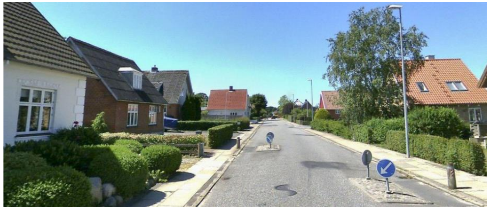
Figur 24 Vejindsnævring med stipassage bag om sideheller på Kærgade. Afmærkningen bør her forbedres med spærreflader og kantlinjer før og efter hellerne.
