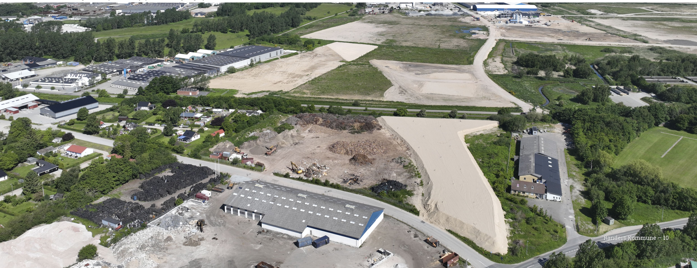
Foto af forbelastning af den nye havnevej syd for Kristrup Engvej.
