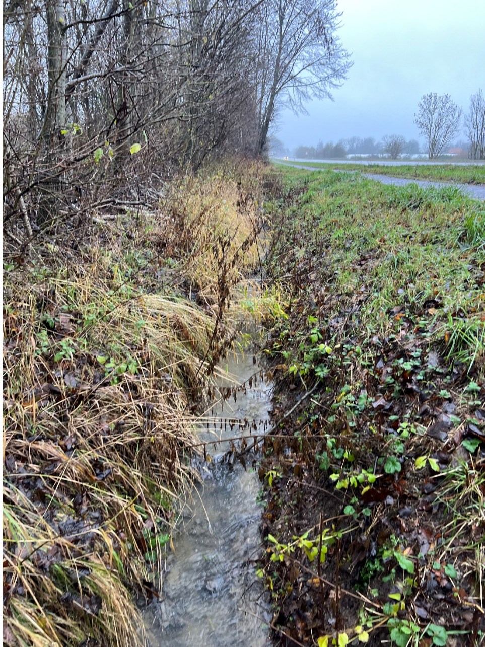
Figur 4 Foto af vejgrøft langs cykelstien ved Gl. Aarhusvej – afvandingen er ikke påvirket væsentlig af trykvandet.
