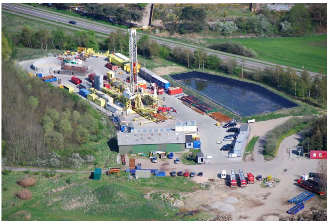
Foto 1 En boreplads med borerig og testbassin i baggrunden (boring ved Sønderborg 2010, det færdige anlæg blev idriftsat i 2013 (Dansk Fjernvarme 2019)
