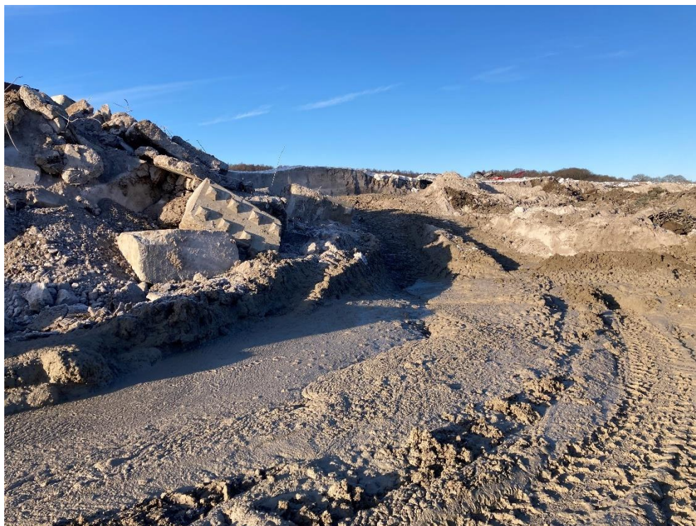
Figur 6: Foto fra den 6. januar 2024. Den lodrette grå flade (bagerst i billedet, midtfor) viser et stort brud i den oprindelige jordbund.
