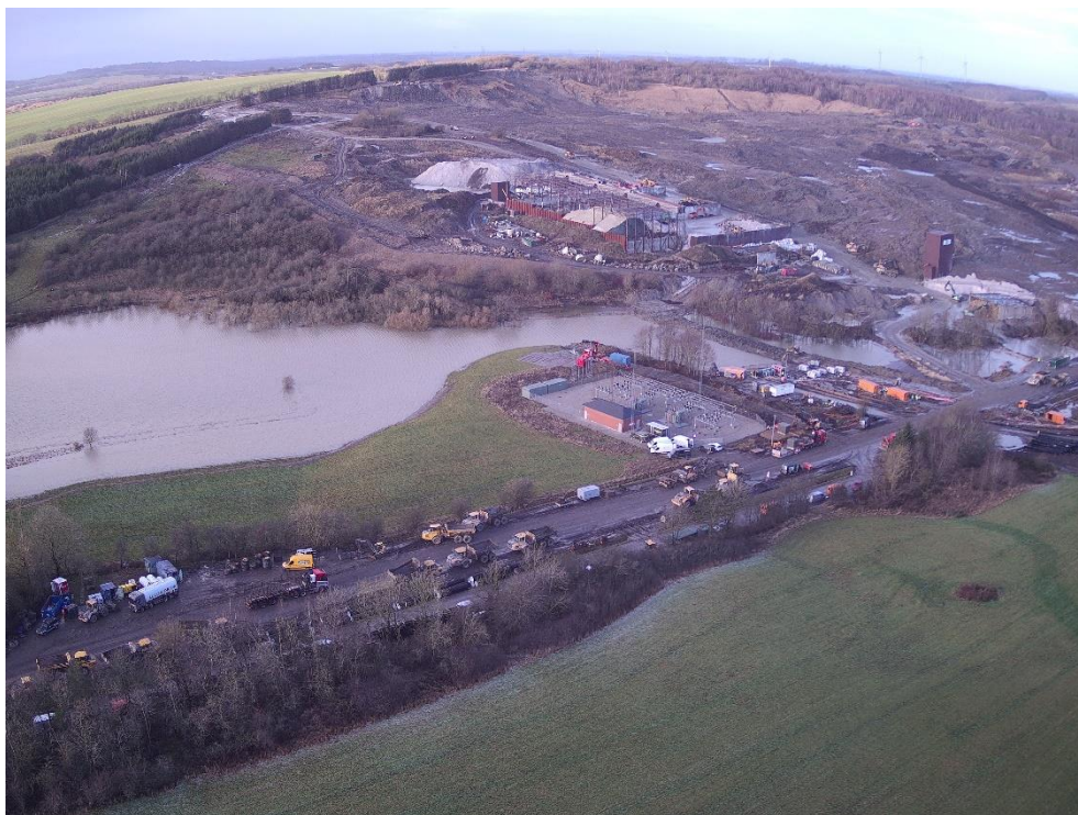
Billede 1: Området set fra sydøst. Alling Å, hvor vandet er rent, er gået over sine breder. Vandet inde på arealet er forurenat. Vandområderne er adskilt med en dæmning, som lige er opført. Der pumpes vand fra Alling Å i rør over til den eksisterende Alling Å lige syd for Ølst by. Jordskredet kan ses øverst til højre. Området ligger fra kote 75 ned til kote 20. Det har faldet mod Alling Å og landevejen Gl. Århusvej.
