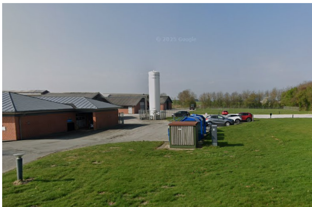
Billede 2: Billede af eksisterende kryotank der fjernes, og den nye tank placeres samme sted. (Google gadefoto 2025).
