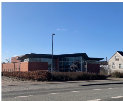
Foto viser bygningen på Mariagervej 117 med den karakteristiske karnap.
