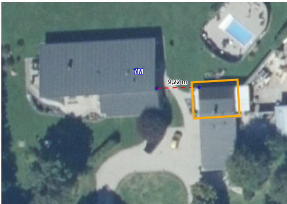
Luftfoto fra 2025 der viser anneks et placering i forhold til den primære bolig
