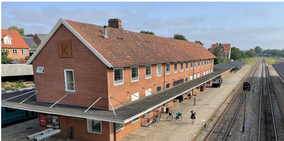
Langå Station, bygning 1 og spor 2 og 3 - foto er taget på ny gangbro mod nord.
