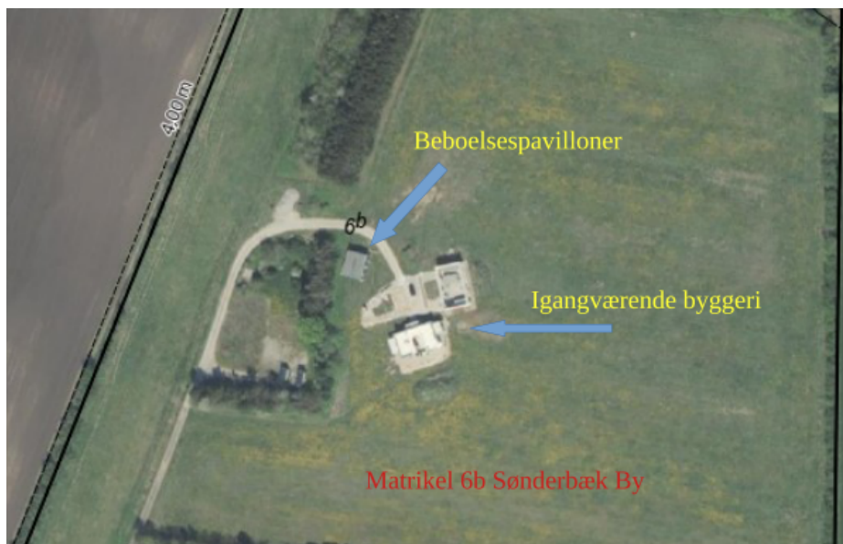
Oversigtskort for ejendommen med placering af midlertidigbeboelse og nyt stuehus under opførelse
