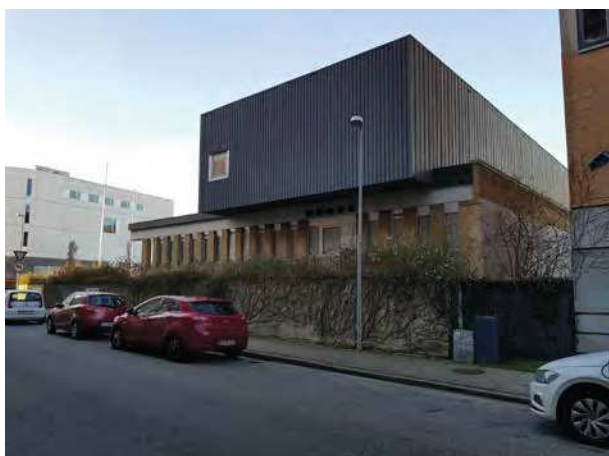
Facade af eksisterende byggeri mod Niels Brocks Gade
