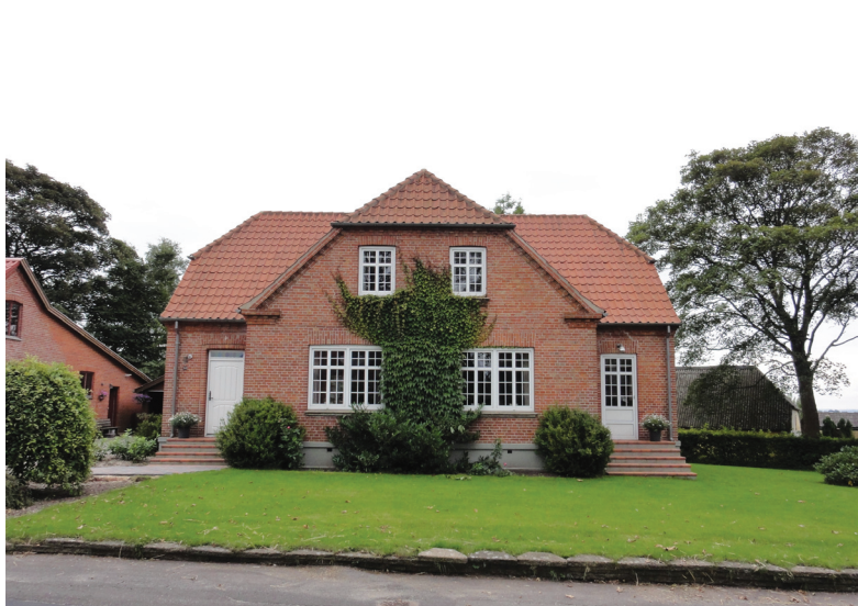
Haldvej 14 er en stor villa i Bedre Byggeskik-stil. Med den symmetriske opbygningen med to gadedøre, har der muligvis boet to familier.
