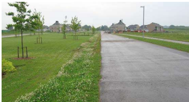
Figur 5: Cverfladevand ledes væk fra kørebane i åben regnvandsrende med vildsom beplantning.
