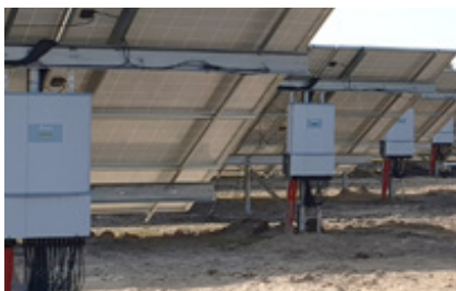
De hvide kasser under solcellerne er invertere, som omdanner jævnstrømmen til vekselstrøm.
