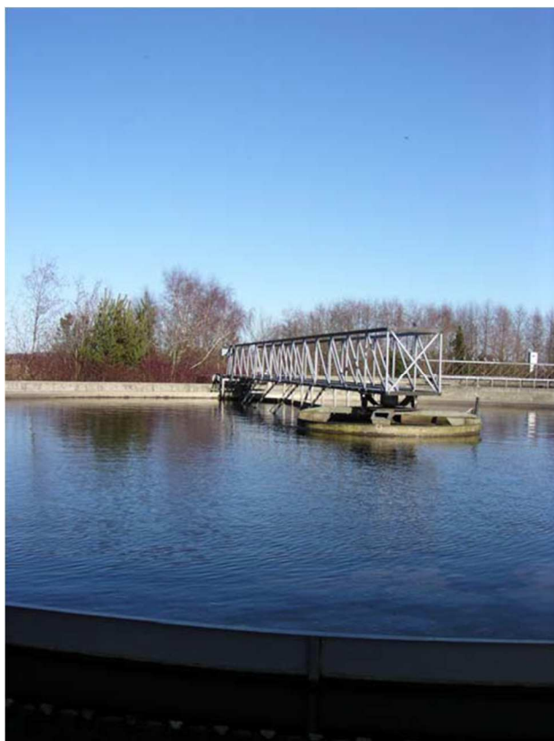
Klaringstank på Langå Rensningsanlæg.
