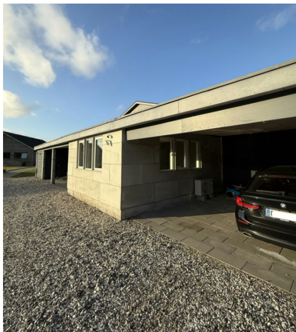
Foto af carport og udhuse, facade set fra sydvest.
