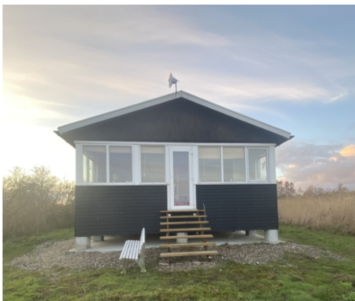
Foto af bygningens østlige facade (facade set fra Randers Fjord), hvor bygningen er hævet og tidligere integrerede overdækning er lukket og inddraget til beboelse.
